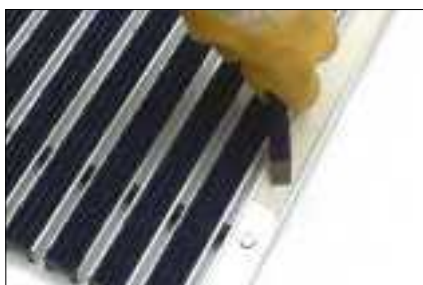
Bien nettoyer le profilé en éliminant soigneusement tous les résidus de colle et autres saletés.
